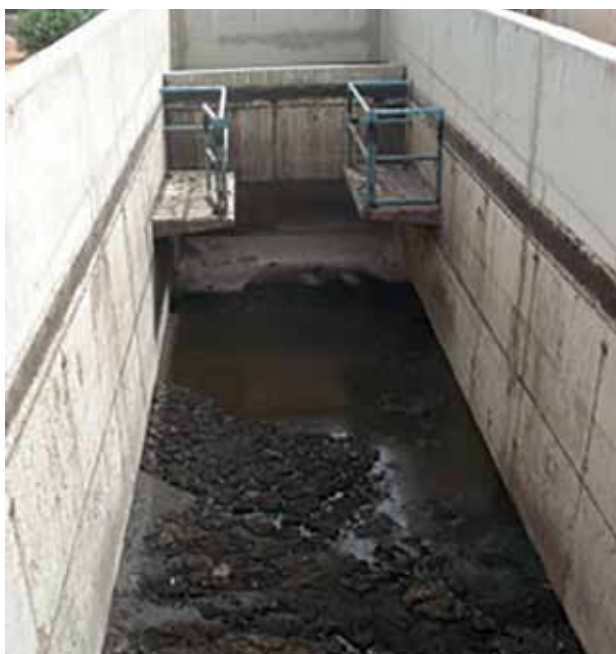
Figura 6.6 Esta capa de nata se ha quedado en el fondo de un tanque de sedimentación-espesamiento, luego del bombeo de la fracción líquida y los lodos espesados, en la ETLF Rufisque, Senegal (foto: SANDEC).
