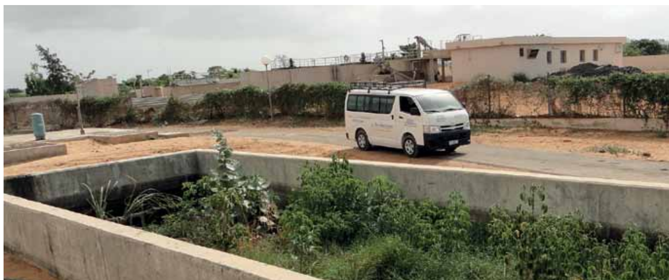
Figura 6.5 Ejemplo de operación y mantenimiento inadecuados de un tanque de sedimentación-espesamiento en África Occidental. La nata no se había sacado durante tanto tiempo que ciertas plantas ya crecían sobre ella. La acumulación de un exceso de lodos o nata impide la debida operación de este tipo de tanque que sirve para decantar sólidos y líquidos (foto: SANDEC).
