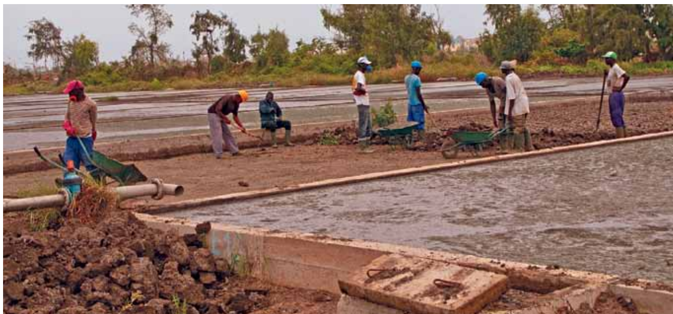
Figura 12.2 Extracción de lodos fecales de un lecho de secado sin plantas para luego aplicarse en la agricultura como una enmienda del suelo (foto: Linda Strande).
