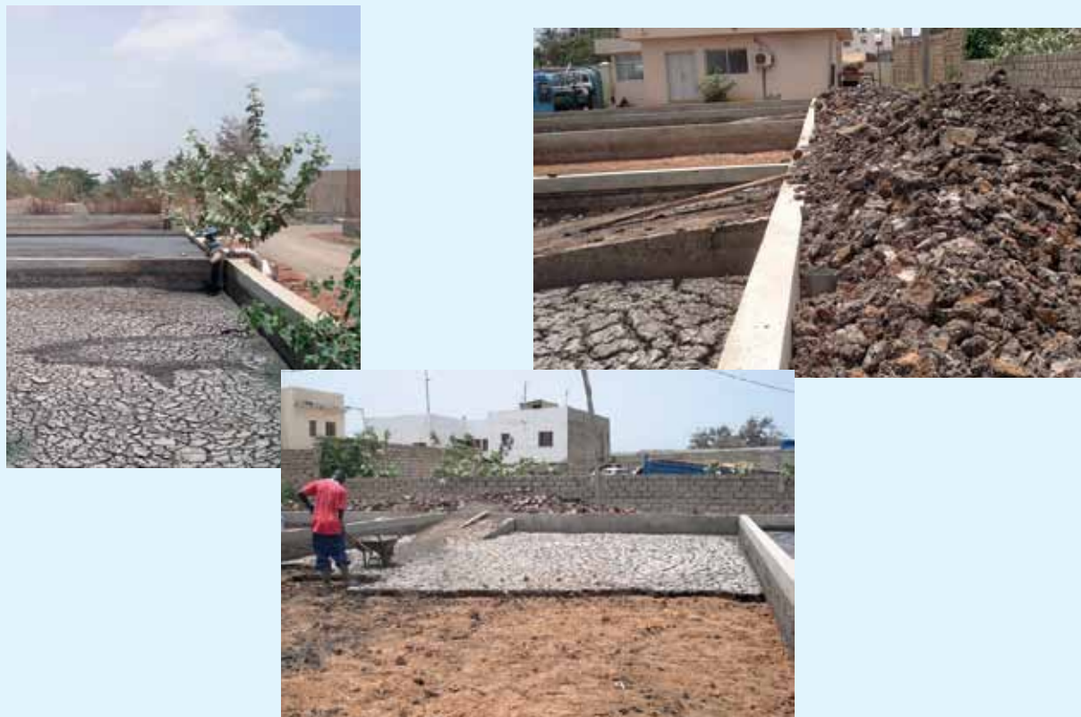
Figura 7.6 Lechos de secado sin plantas, con la acumulación y extracción (der.) de los lodos, en la estación de tratamiento de lodos fecales Cambérène, en Dakar, Senegal (fotos: Pierre-Henri Dodane).
