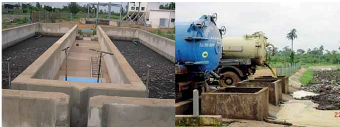
Figura 6.2 Los dos tanques de sedimentación-espesamiento de la estación de tratamiento de lodos fecales Rufisque en Dakar, Senegal (izq.). El ciclo operativo dura 2 semanas (1 semana de uso, otra de reposo) y luego se bombean los lodos a lechos de secado. La laguna de sedimentación-espesamiento en Achimota, Accra, Ghana, tiene un ciclo operativo de 8 semanas (4 semanas de uso, 4 semanas de reposo; der.). Como los lodos se espesan durante 4 veces más tiempo, no es posible extraerlos con una bomba y su retiro es manual (foto: SANDEC).
