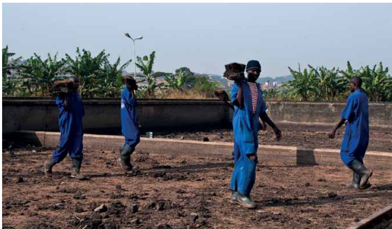
Figura 11.7 Sacando el lodo de los lechos de secado en la estación de tratamiento de Bugolobi en Kampala, Uganda (foto: Linda Strande).
