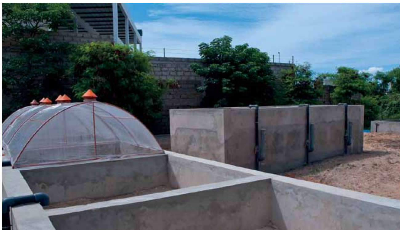
Figura 7.6 Proyecto piloto acerca de la separación del agua presente en los lodos fecales, mediante invernaderos con ventilación activa y pasiva, dentro de la estación de tratamiento de lodos fecales Cambérène, en Dakar, Senegal (foto: Linda Strande).
